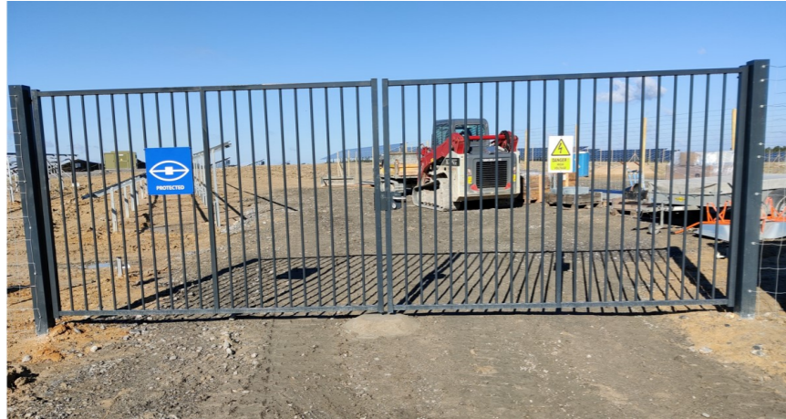
Photographie 4: Exemple d'un portail de la centrale photovoltaïque
