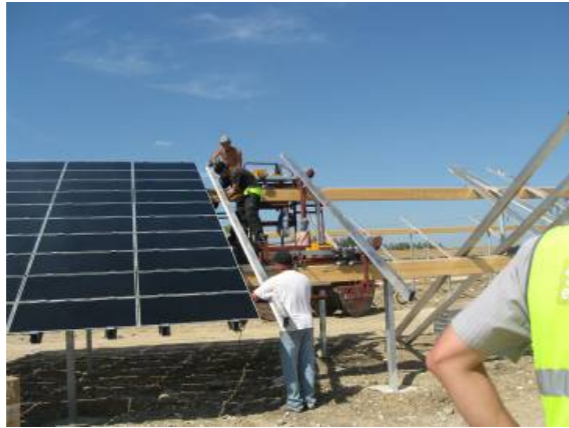
Photographie 10 : Montage de modules sur des supports fixes
