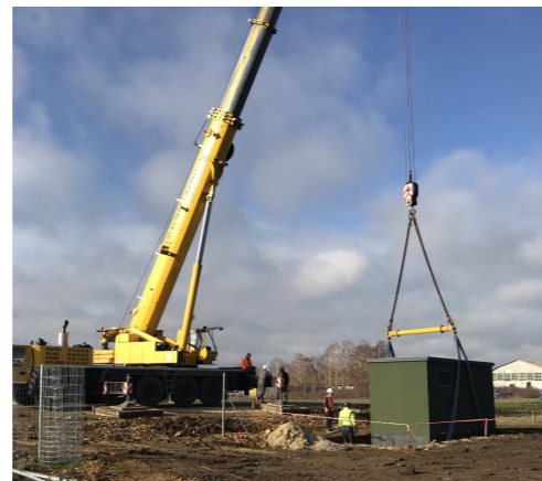
Photographie 11 : Déroulage et pose des câbles (à gauche), exemple de montage d'un poste de conversion (à droite)
