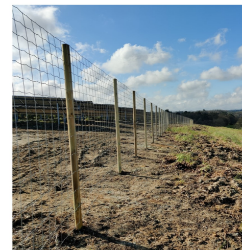
Photographie 3 : Exemple de clôture d'une centrale photovoltaïque
