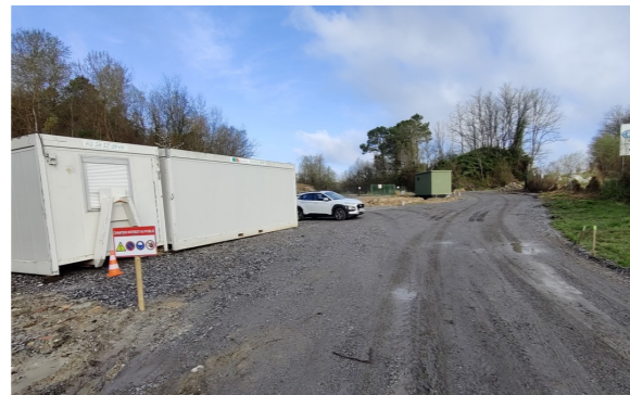
Photographie 7 : Installation de la base-vie
