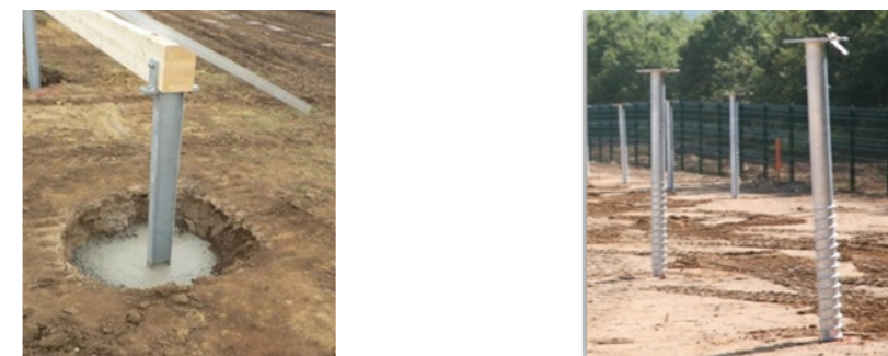
Photographie 9 : Fondation béton (à gauche) ; fondation vis (à droite)
